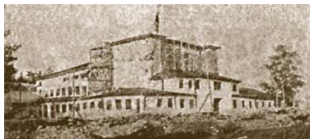
Строящийся Дом культуры им. Ленина. Фото из заводской газеты «Большевик». № 25. 1929 г.
