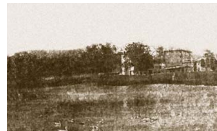
Строящийся Дом культуры им. Ленина со стороны пруда. Фото из заводской газеты «Большевик». № 19. 1929 г.
